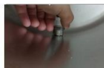
2. Ослабить и вывернуть винт сетчатого фильтра.
